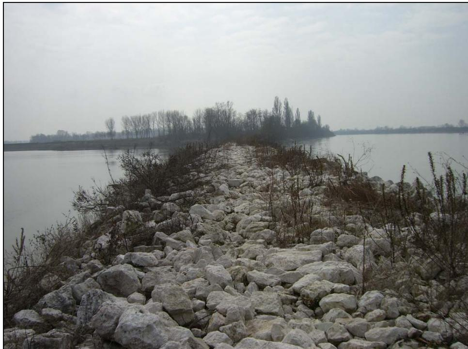
Figura 11 Pennello in corrispondenza della Curva n°33 - a destra della foto il fiume Po
