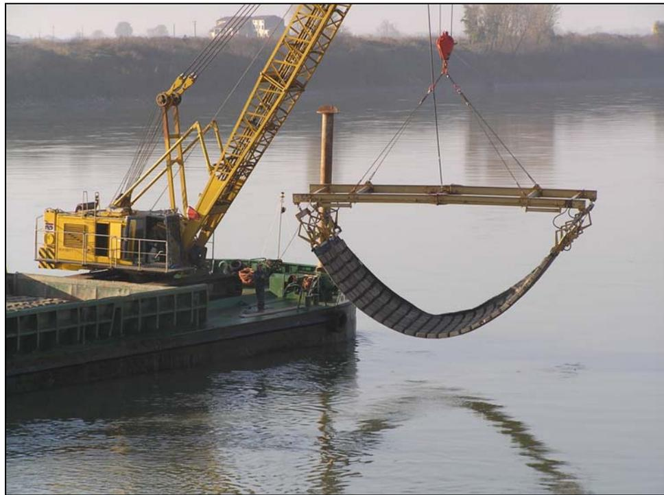
**Figura 12**                      **Posizionamento telone zavorrato**
